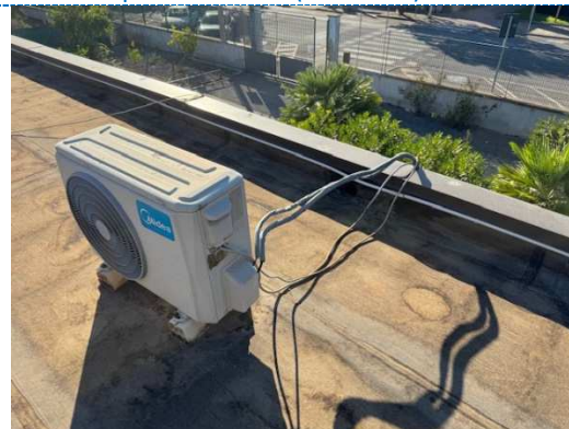
Alcuni impianti elettrici (tubazioni) da sistemare
