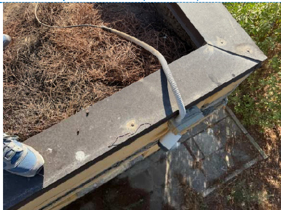
Alcuni impianti videosorveglianza (tubazioni) da sistemare
