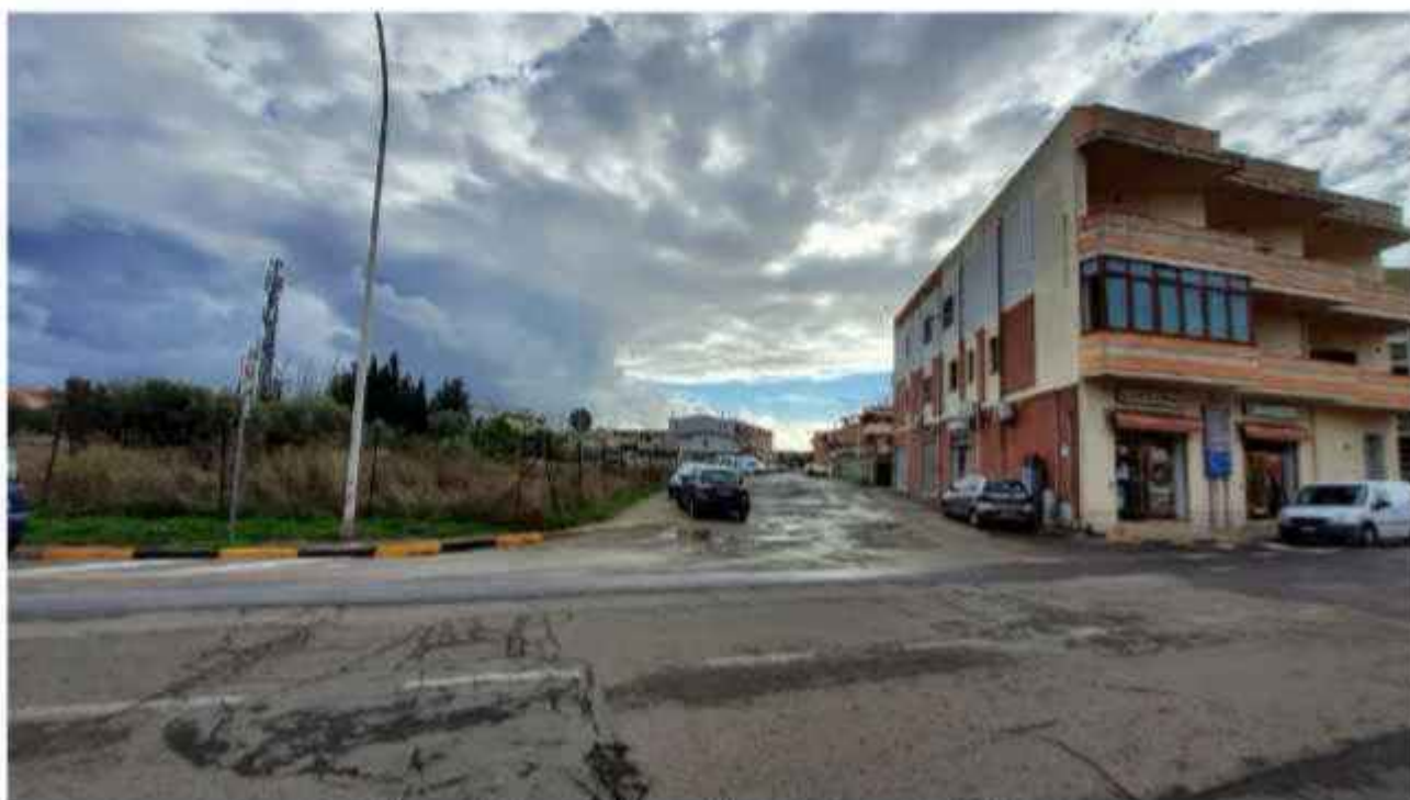
Vista area di intervento dalla via Villono Veneto incrocio via Meucci
