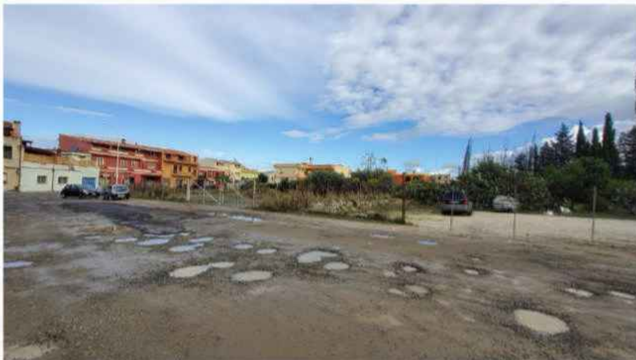
Vista area di intervento dalla via Meucci
