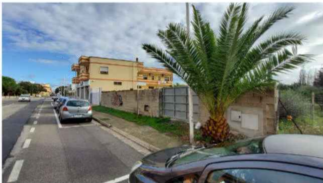
Vista area di intervento dalla via Vittorio Veneto
