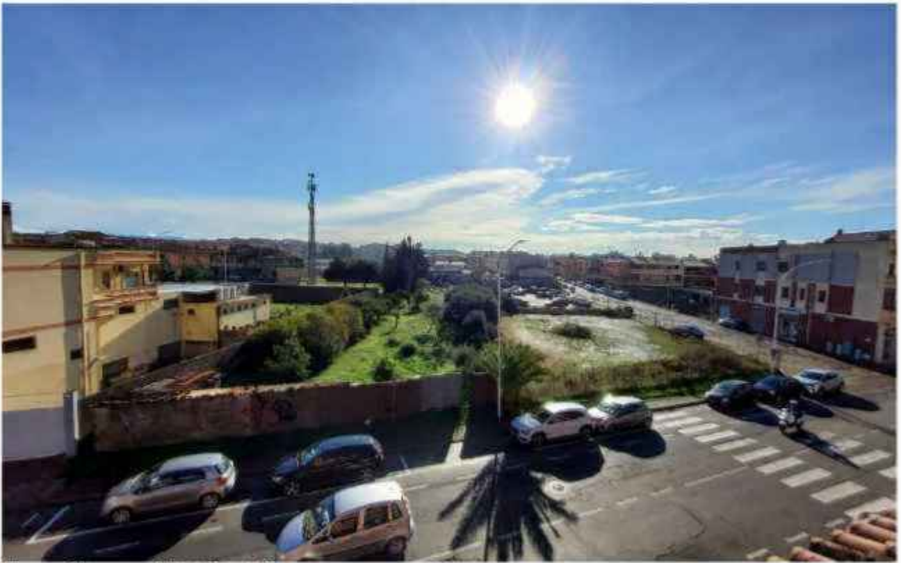
Vista area di intervento dalla via Vittorio Veneto
