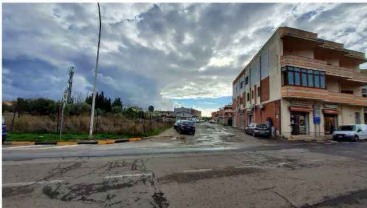
Vista area di intervento dalla via Vittorio Veneto incrocio via Meucci
