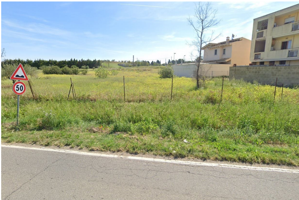
Foto 2 – Dalla SP n. 9 verso la zona agricola su cui si prevede di realizzare la nuova arteria viaria
